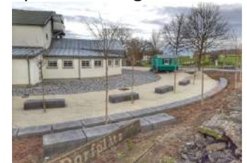
Baumaßnahmen bis Januar d. J. (c) Stadt Arnsberg 2021
